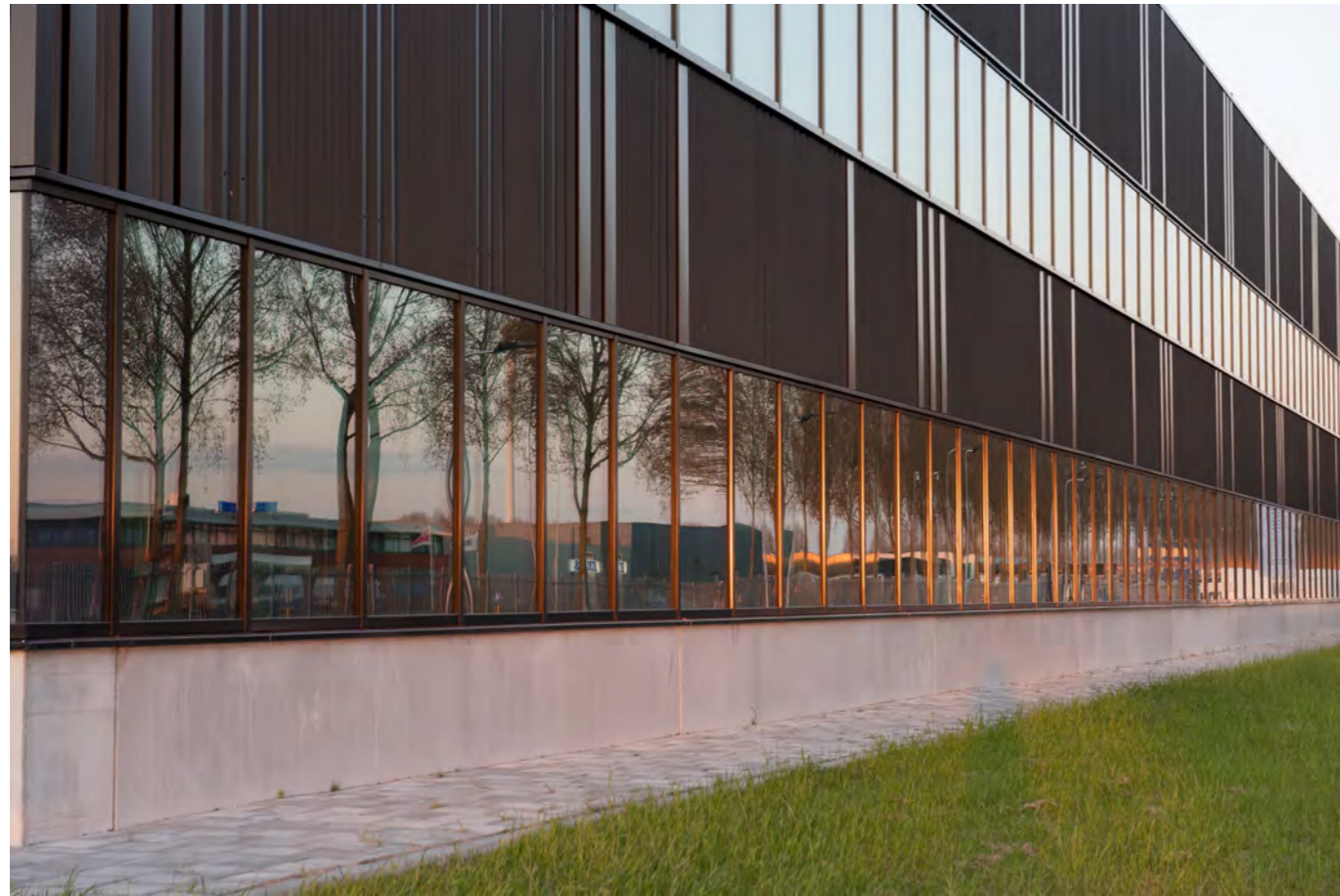
Reflectie van de bomenrij in het kantoorgedeelte. De gevel heeft een duidelijk patroon dat verwijst naar de gebruiker van het gebouw
