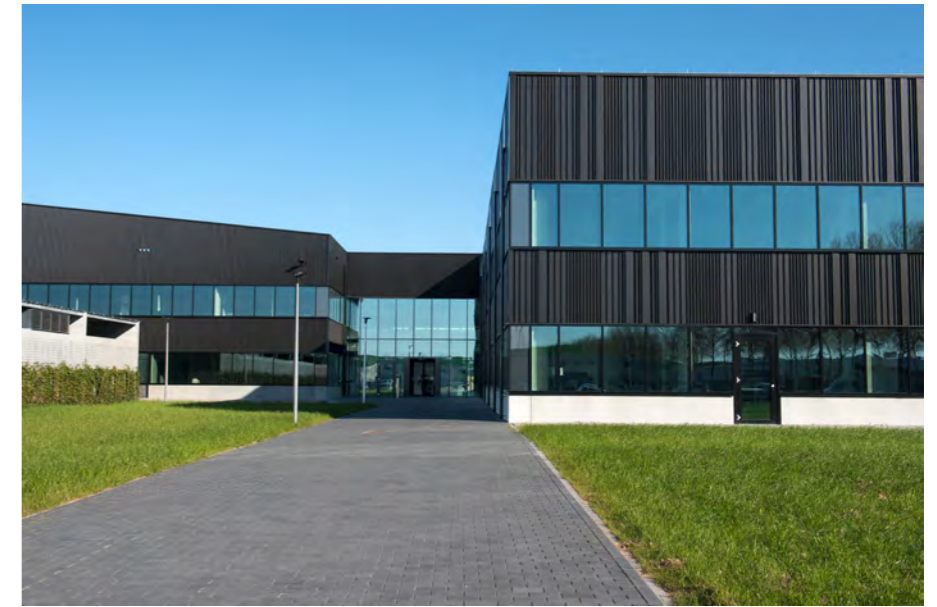
Entree voor de werknemers aan de kant van de parkeerplaatsen. Het betonnen bijgebouwtje zal geheel volgroeien met de aangebrachte beplanting
