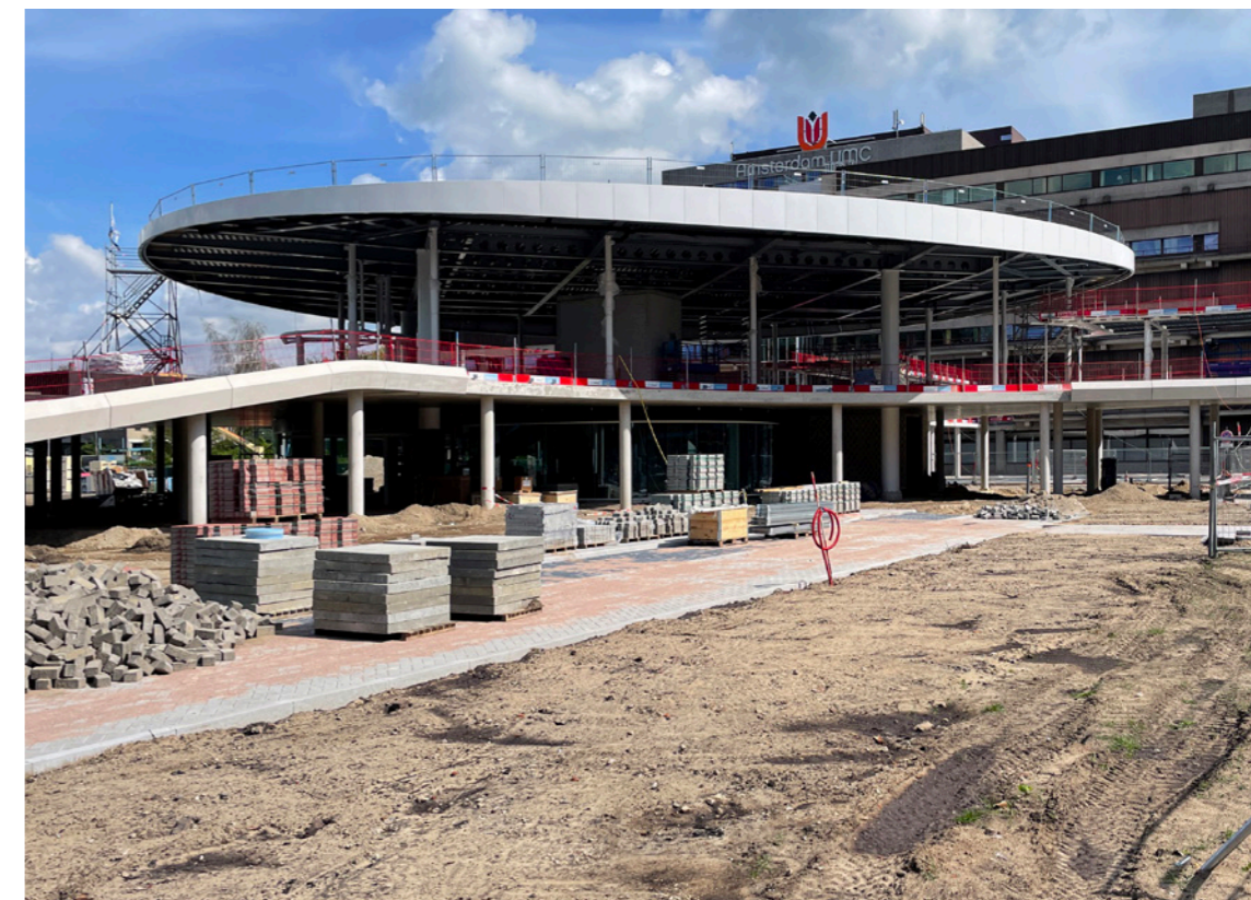
Door voor de constructie voor staal te kiezen was het mogelijk om gevoelige detaillering zoals bijvoorbeeld de gebogen dakrand en de vrije vorm en hoogte van de glazen puien ook echt waar te maken.
