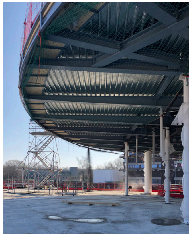
Ronde stalen kolommen ondersteunen de vliesgevelprofielen en de uitkragende stalen dakliggers
