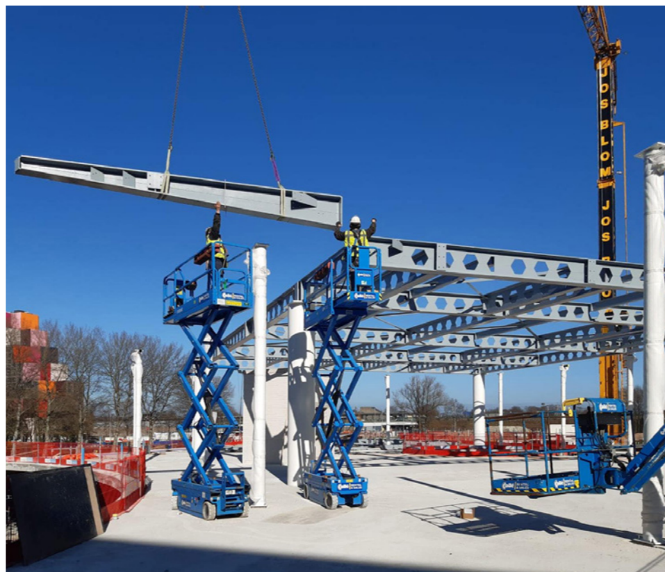
De 4 kolommen dragen een rechthoekig frame van stalen raatliggers waaraan aan alle zijden stalen dakliggers uitkragen. Deze liggers hebben op sommige plekken een overstek van wel 12 meter.
