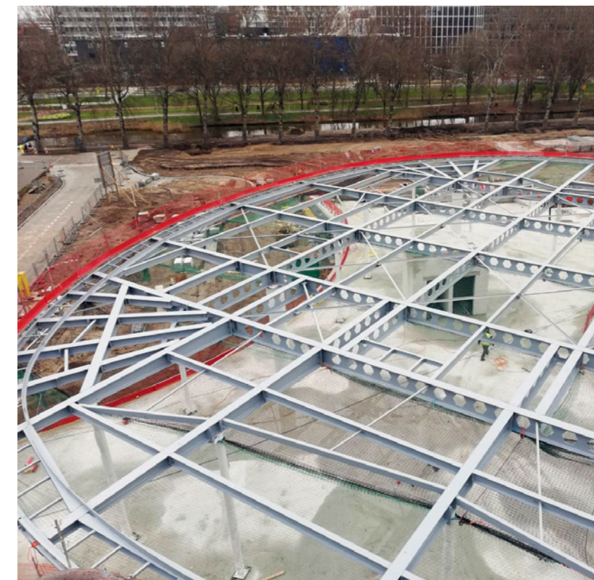
De 4 kolommen dragen een rechthoekig frame van stalen raatliggers waaraan aan alle zijden stalen dakliggers uitkragen. Deze liggers hebben op sommige plekken een overstek van wel 12 meter.
