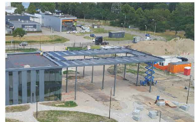
De operatie met twee kranen werd zeer snel voltooid. De luifel werd in één dag gemonteerd. Vervolgens werden in twee weken de PV panelen met hoogwerkers geïnstalleerd.
