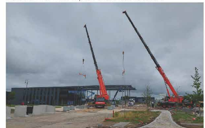
De operatie met twee kranen werd zeer snel voltooid. De luifel werd in één dag gemonteerd. Vervolgens werden in twee weken de PV panelen met hoogwerkers geïnstalleerd.
