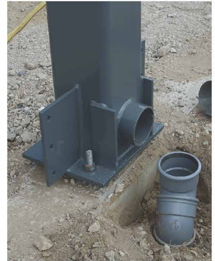
Verholen hemelwaterafvoer in de kolomvoeten.
