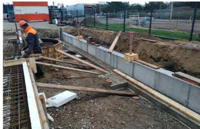
De funderingsstrook van de luifel (rechts) is gekoppeld aan de fundering van het hoofdgebouw (links in aanbouw).
