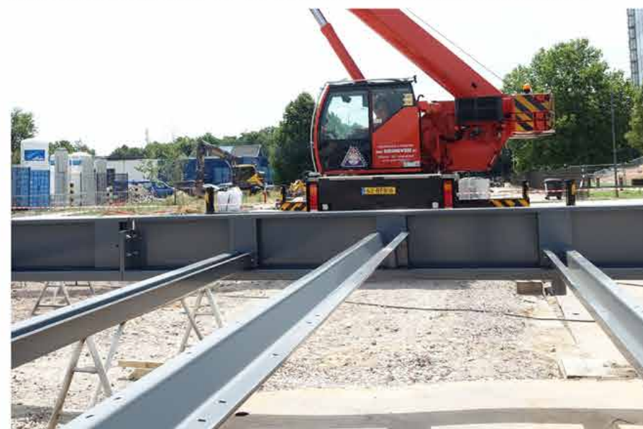
De goten zijn hoog-laag geplaatst om zo de panelen op afschot te monteren.
