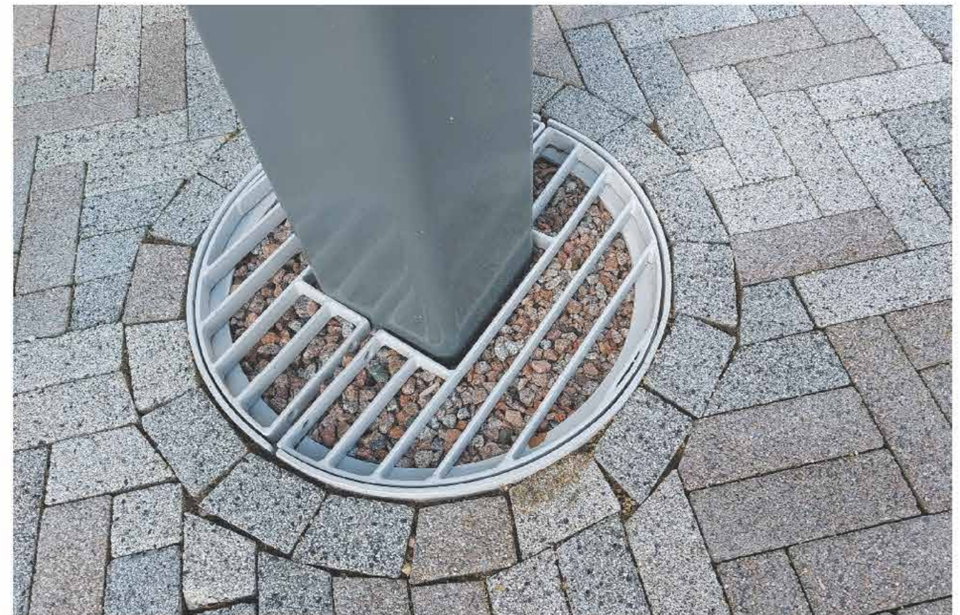
Resultaat van de roosters rondom de kolomvoeten.
