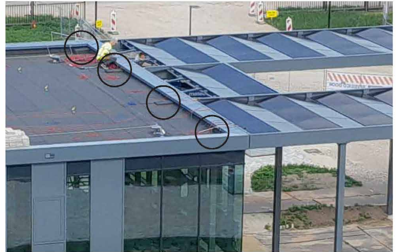
Boven: foto van het dak tijdens uitvoering, waarbij de zetwerk dakrand en de verbinding met de luifel te zien is. De 'bulten' in de dakbedekking op vier plekken zijn het resultaat van de extra isolatie waarmee de HEA160 consoles zijn ingepakt.
