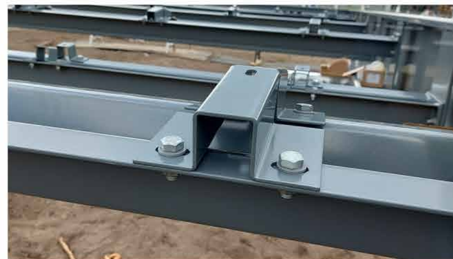
Omega verbindingsbeugels om de PV panelen op te bevestigen.
