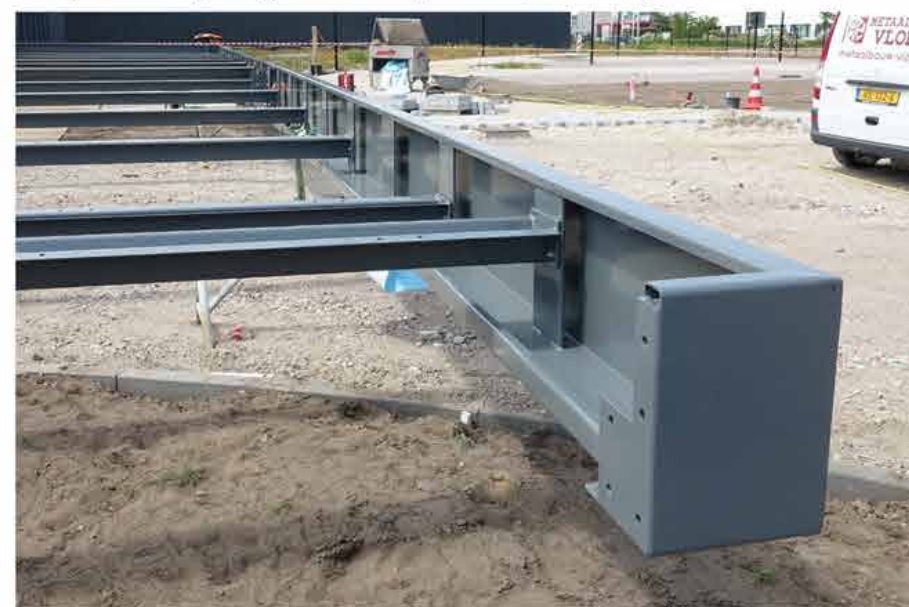
De J-vormige langsbalen van de luifel en aansluitingen van de omega goten.
