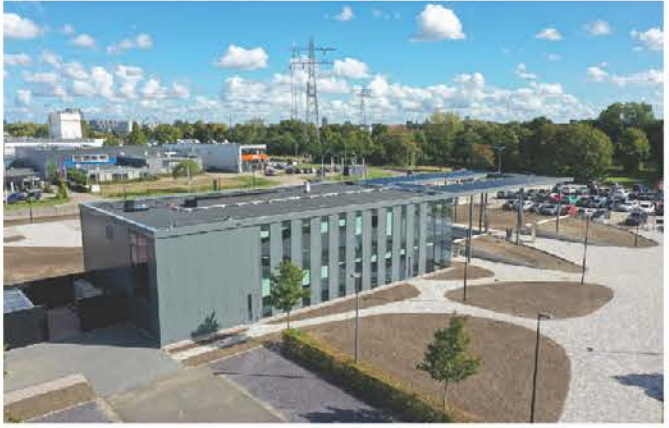
Zuidwestgevel van de portiersloge, waar het logistiek plein is gesitueerd.
