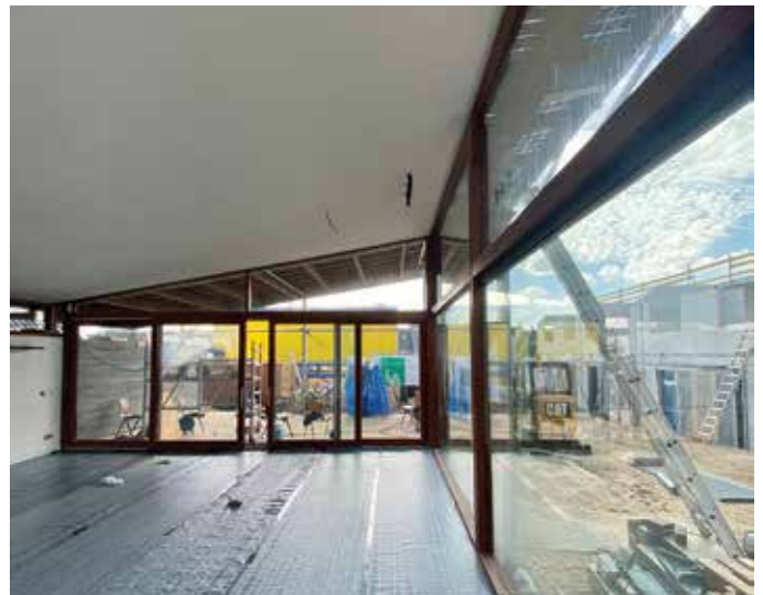
Het oplopend plafond geeft de (uiteindelijk) compacte kamers ruimtelijk gevoel.
